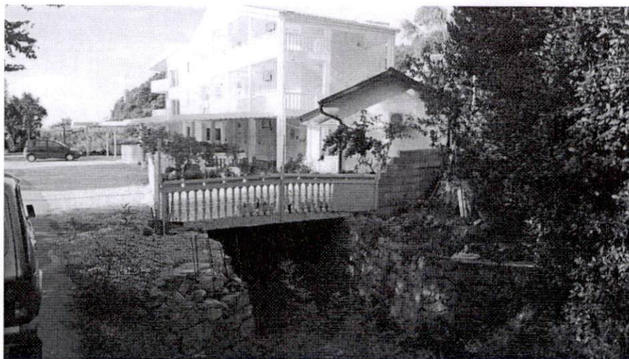
Prilog br.45: Privatni objekat preko bujičnog vodotoka (Buljarica)
