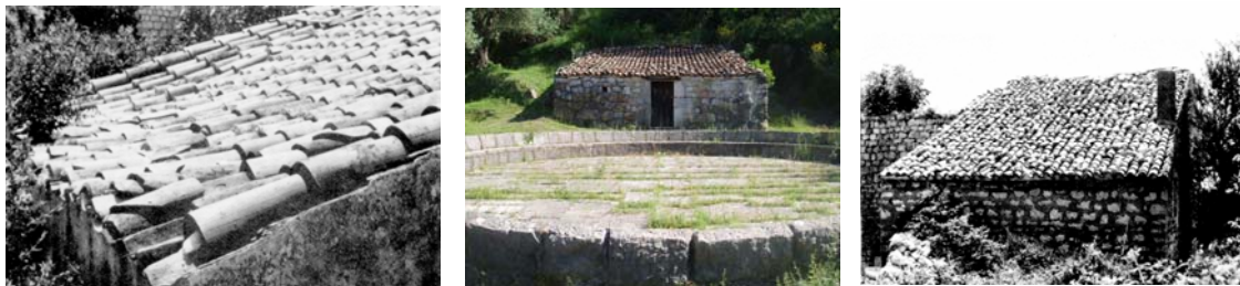
Slike 42 - 44: Kupa kanalica kao krovni pokrivač na paštrovskim kućama
