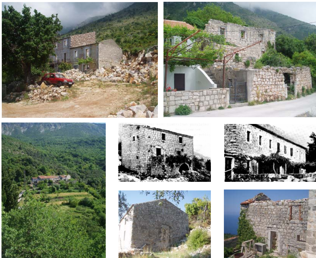
Slike 23 - 29: Oblik i dimenzije kuće, fasade i otvora u starim paštrovskim naseljima
