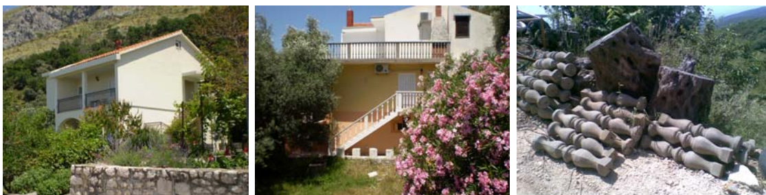
Slike 56 - 58: Primjeri upotrebe neodgovarajućih fasadnih materijala i ukrasne betonske galanterije
