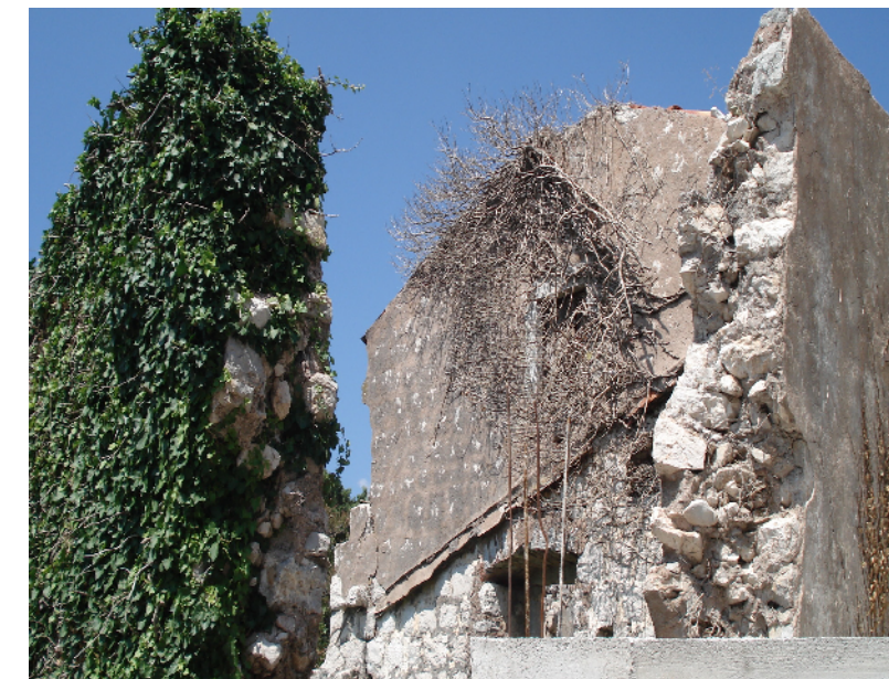
Objekti za rekonstrukciju u starom seoskom jezgru
