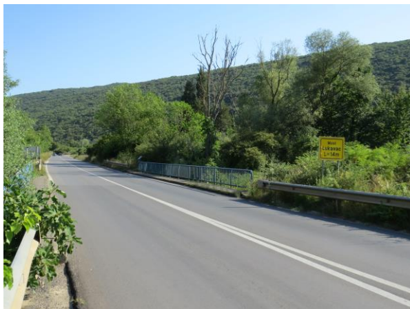
Slika 9. Most na vodotoku Lukavac
