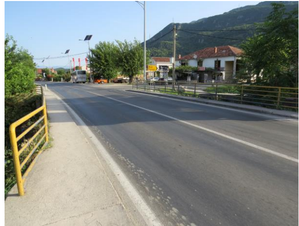
Slika 3. Most na vodotoku Drenovštica
