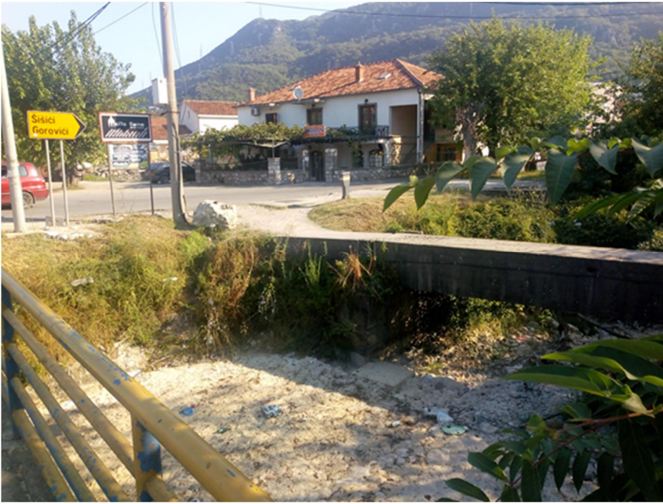
Slika 1. Lokacija 1 Kanal rijeke Drenovštice
