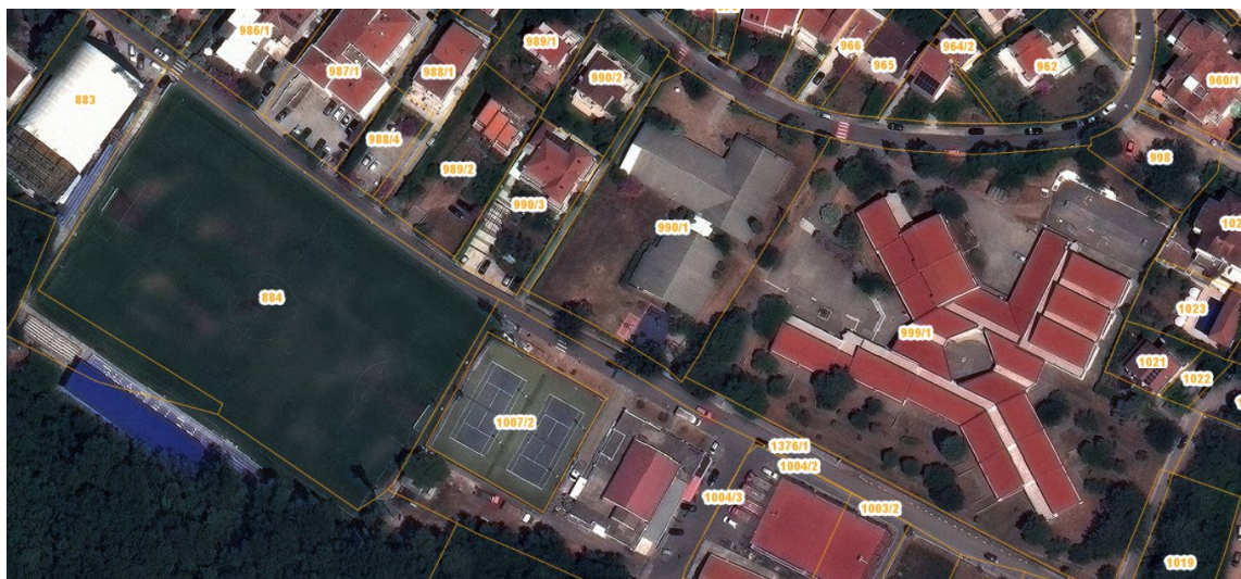
Na lokaciji UP 22 u bloku 11 postoji montažni objekat vrtića.
