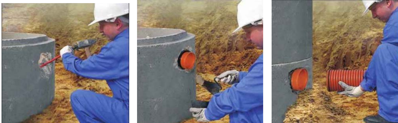
Slika 11: Spajanje PP cijevi na betonski šaht
