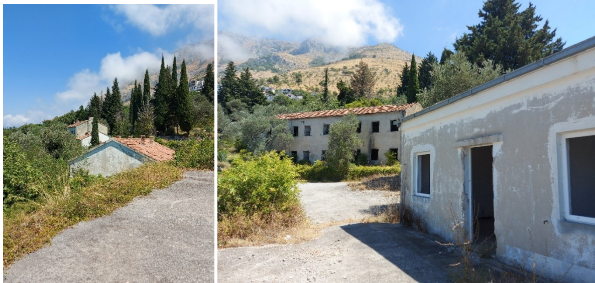
Kasarna – lokacija, izgled i stanje objekata i prostora
