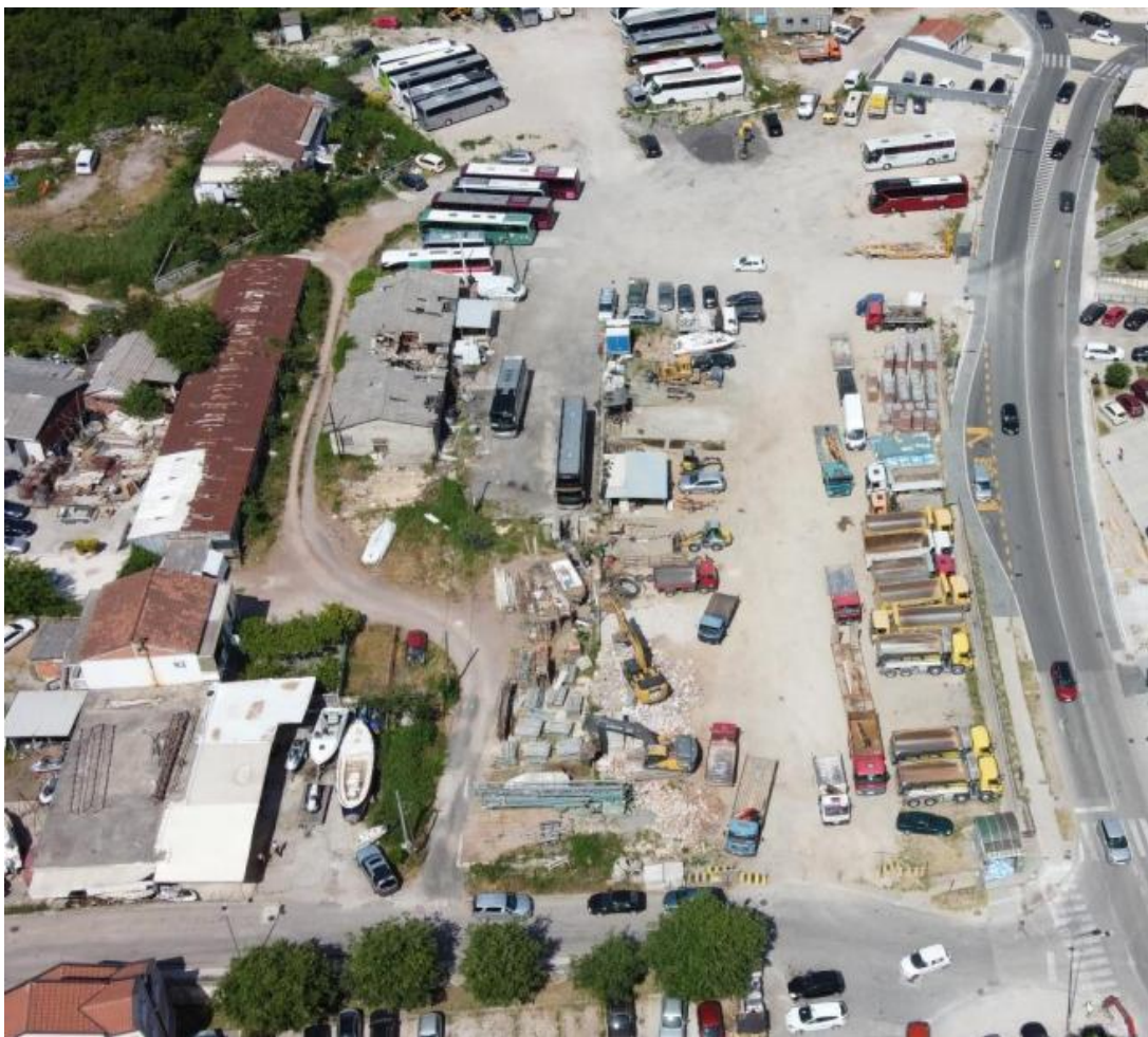
Slika 3. Postojeći izgled lokacije objekta
