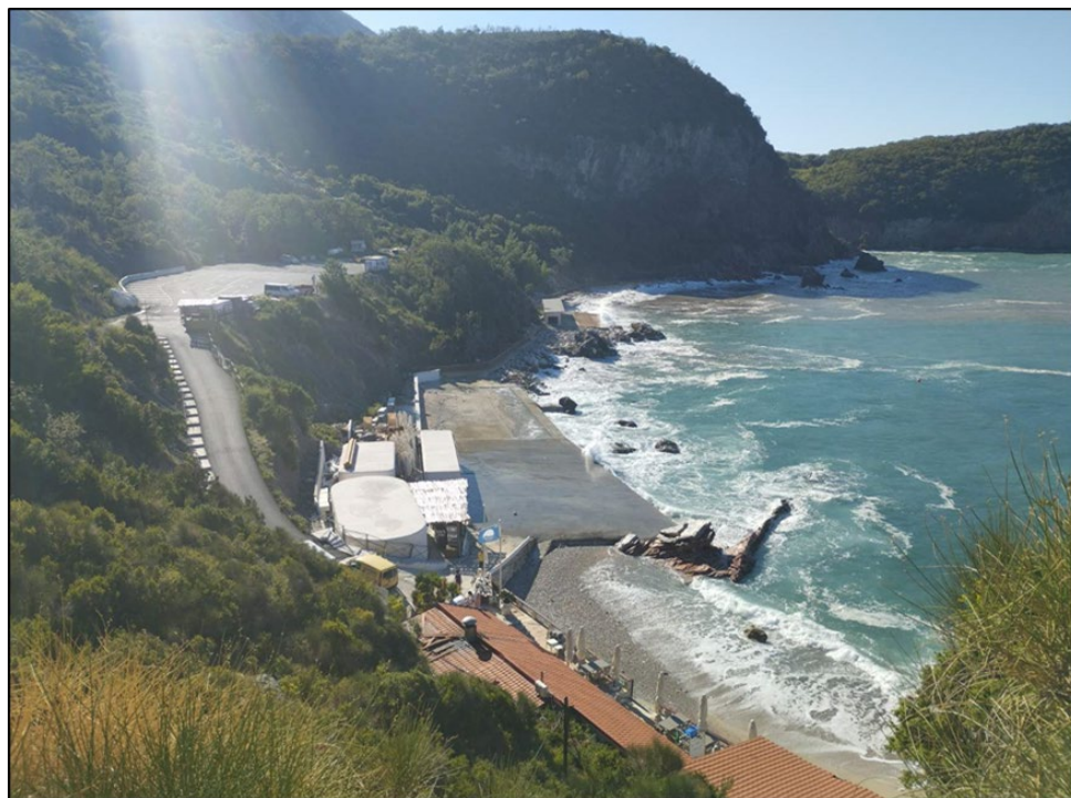
Slika 15. Prikaz postojećih objekata i pristupne infrastrukture na predmetnoj lokaciji
