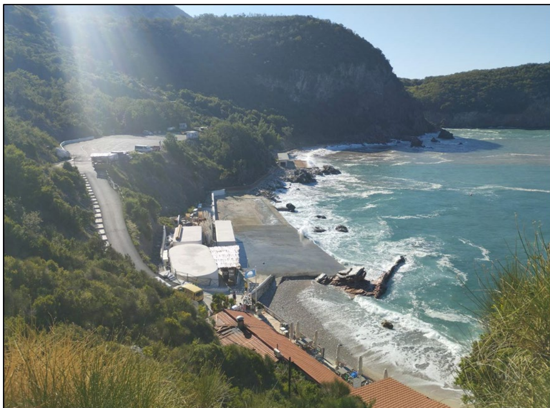
Slika 4. Izgled predmetne lokacije
