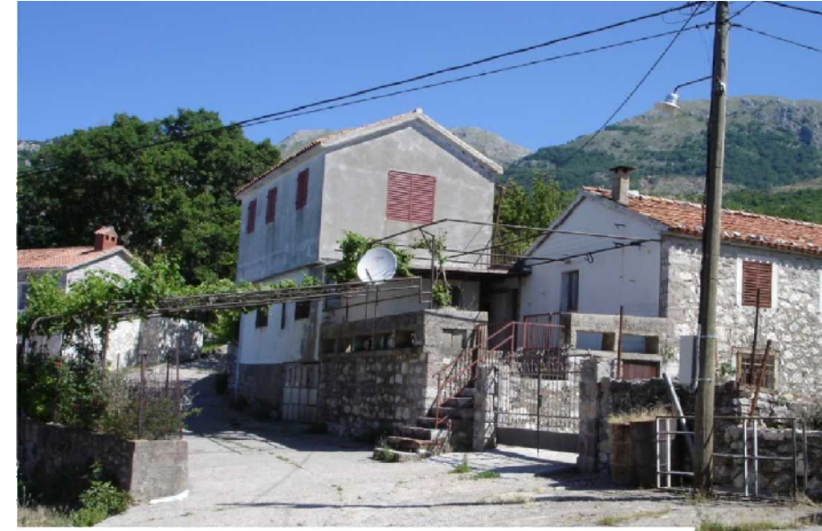
Ukupan broj postojećih objekata koje su u funkciji je oko 40.
