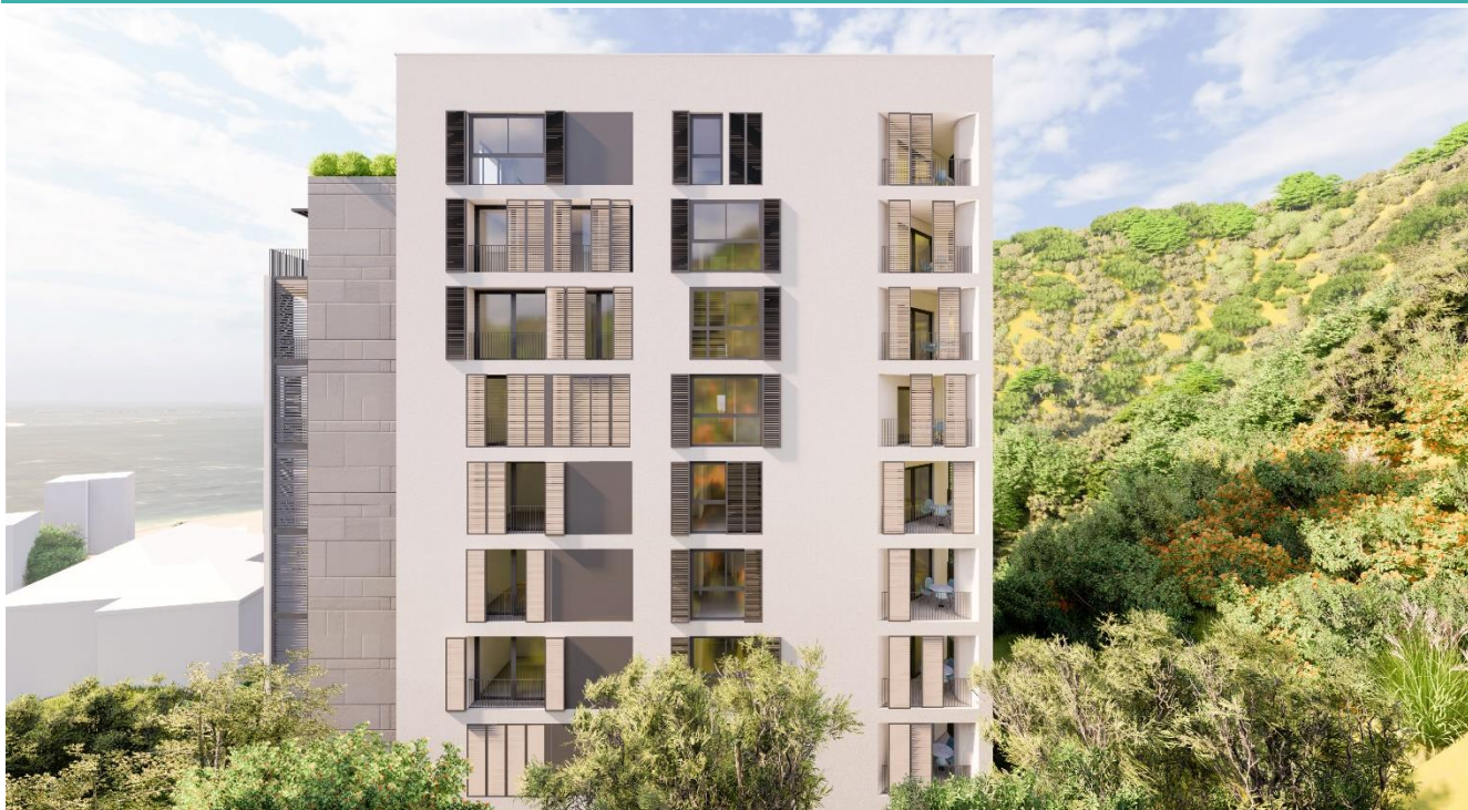
Prilog br. 5. 3D prikaz novoprojektovanog objekta na kojem su vidljive pokretne žaluzine grafitno sive boje kao zaštita od sunca.
