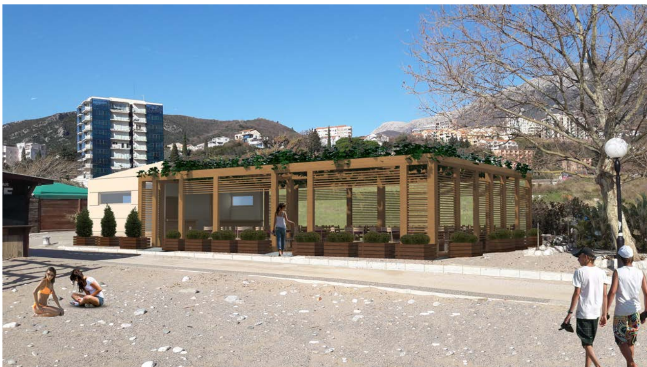
sl. 1 IZGLED OBJEKTA SA JUGOISTOČNE STRANE
